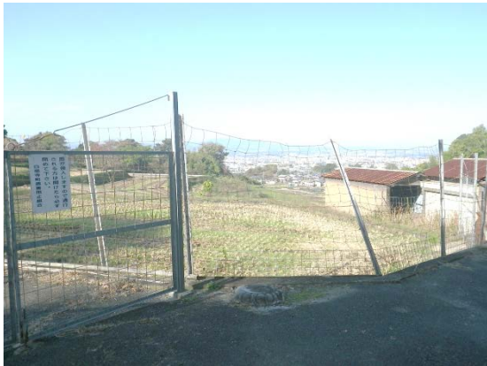
図11 白毫町に設置された防鹿柵
